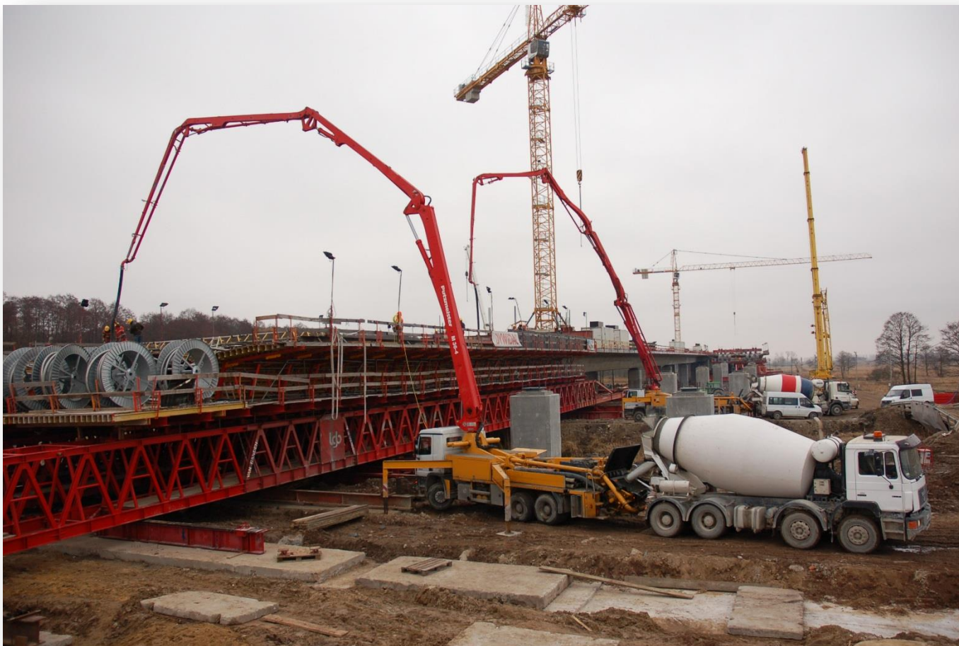
Budowa ustroju nośnego (10.11.2012)
