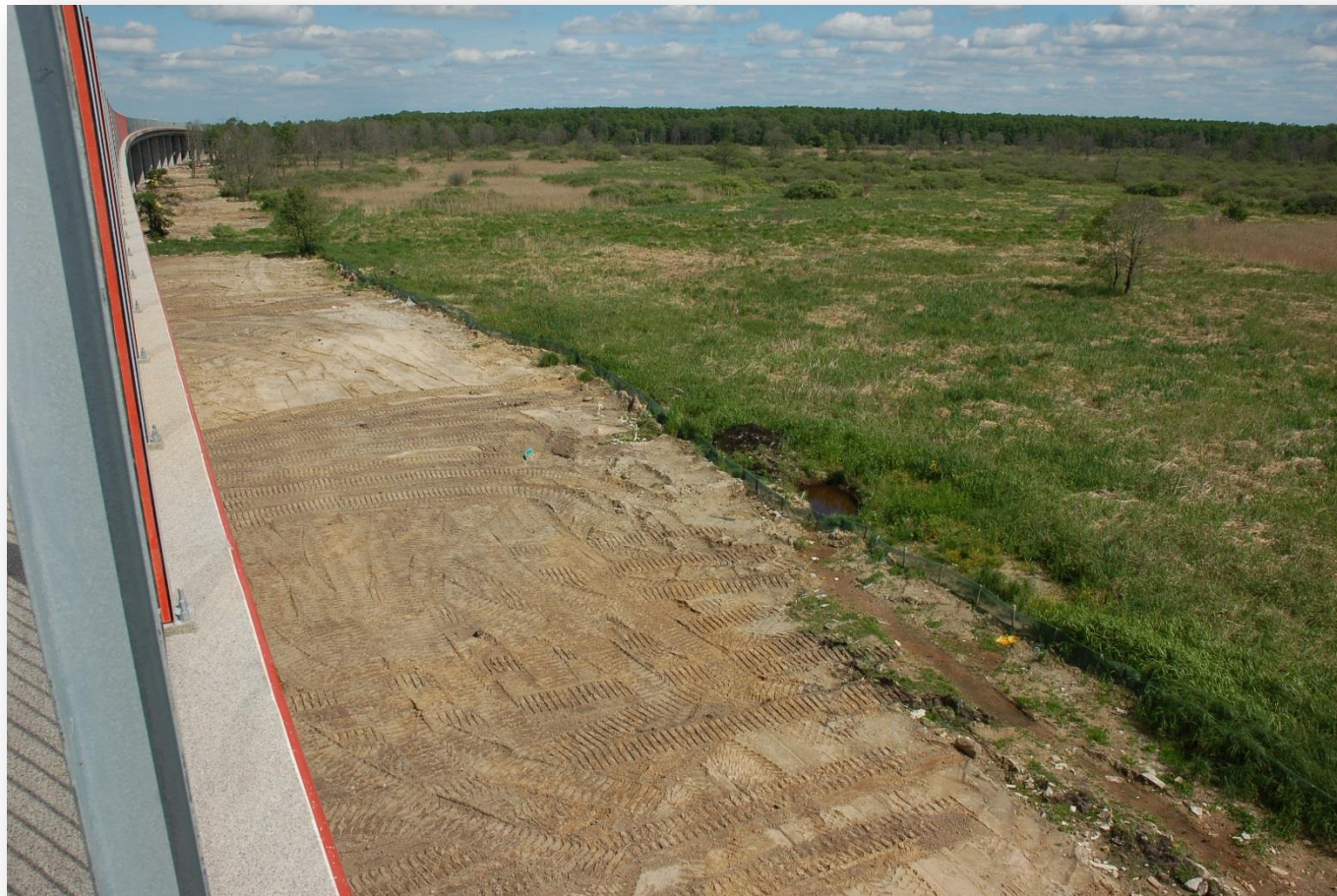
Teren budowy przed rekultywacją (10.06.2012)
