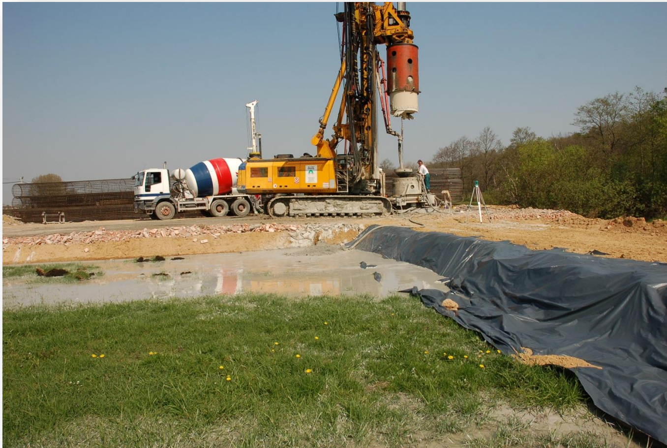
Platforma do wiercenia pali wielkośrednicowych (29.04.2011)
