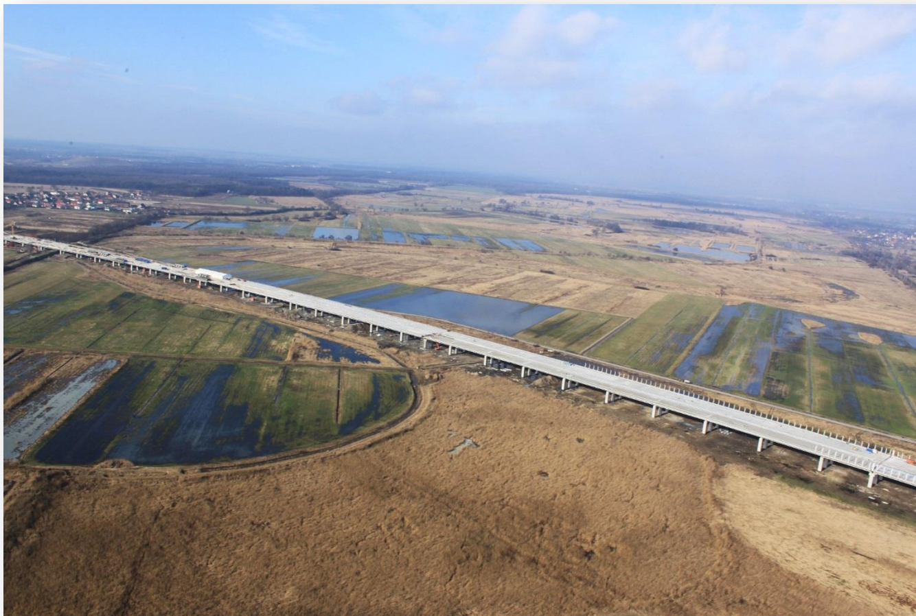
Autostrada A8 - budowa estakady w dolinie Odry (źródło: www.gddkia.gov.pl )
