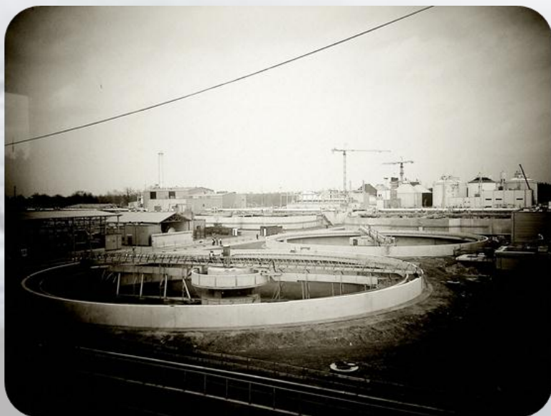
Foto: Oczyszczalnia ścieków Czajka w Warszawie
